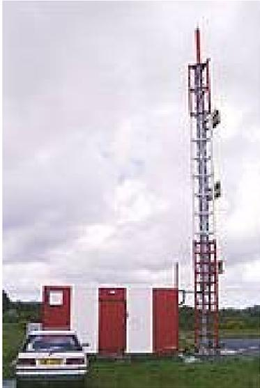
**Les systèmes de radionavigation nécessitent souvent des installations/antennes sur le sol. Elles sont soumises au vent, pluie ... qui peuvent les endommager ou les dérégler. L'installation et la maintenance coûtent chers.**
