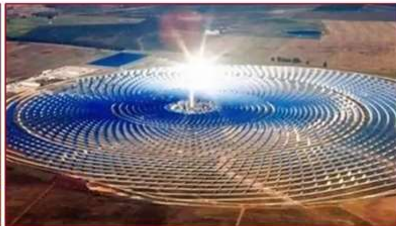
Centrale solaire Noor 1 Ouarzazate
